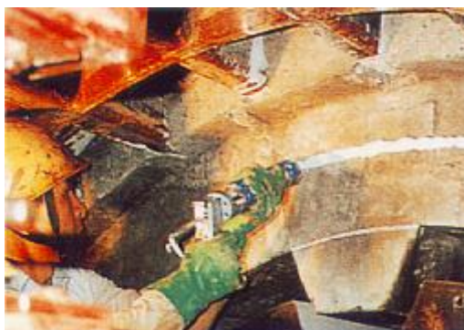
Pro spárv v betonu in situ
